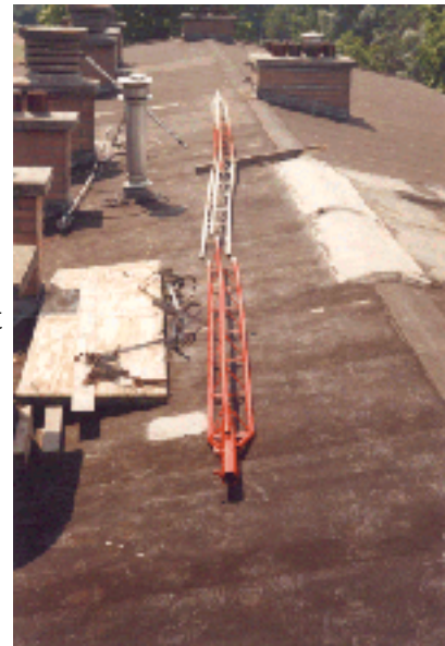
Zomer 1996. Voorbereidingen voor het plaatsen van een nieuwe mast.
